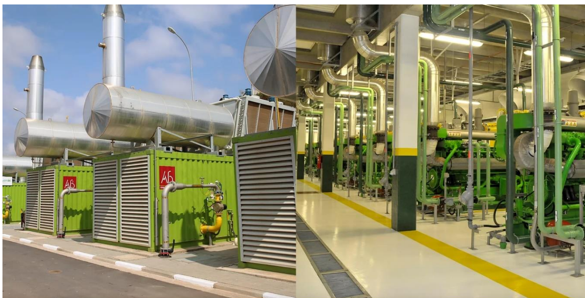
Figura 9 – Foto motogeradores à biogás.
