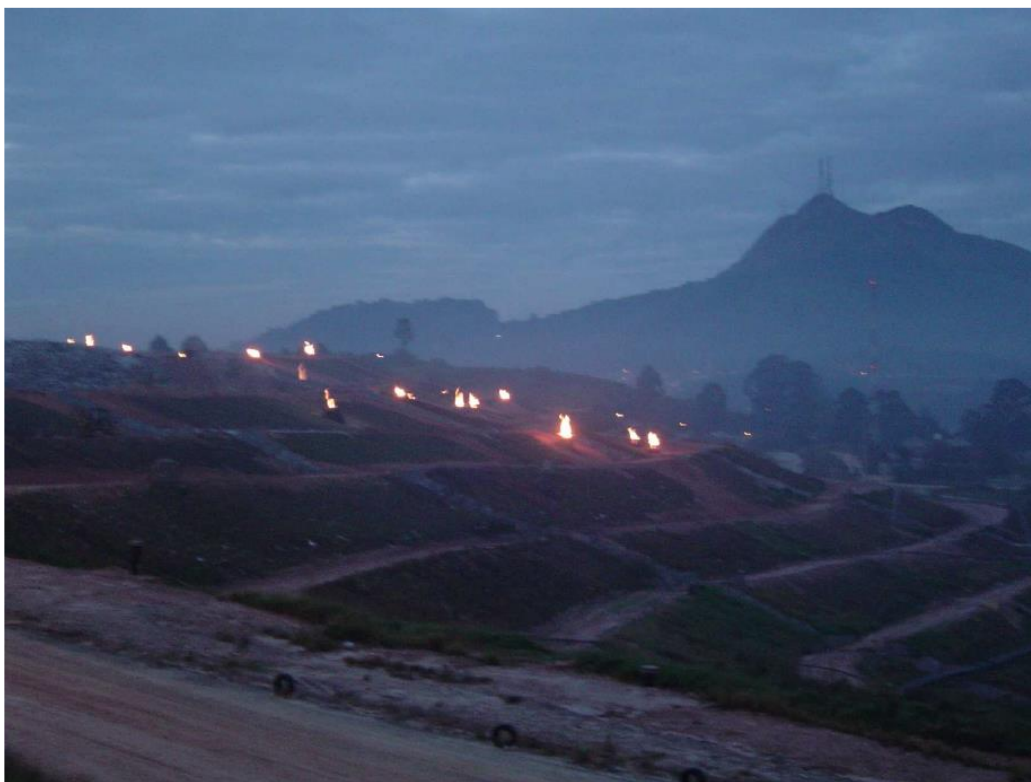
Figura 3 – Biogás sendo queimado diretamente nos poços no Aterro Sanitário Bandeirantes.
